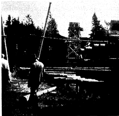
Mahlasuru immutusseadeldis Viesates, Lätimaal. Tagaplaanil näha immutustoru paagiga
