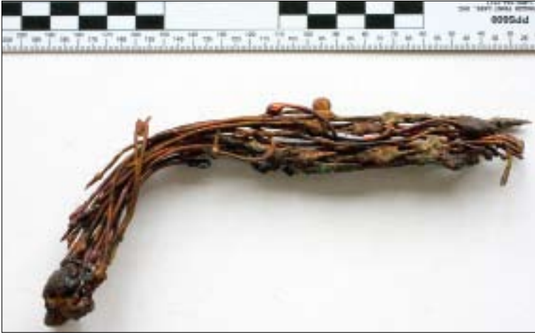
Foto 14. Välise kõrge temperatuuri poolt tekitatud kahjustused vaskjuhtmetel.
