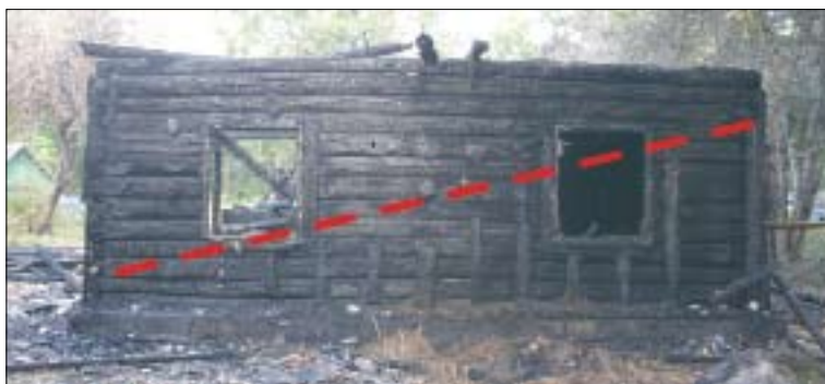
Foto 7. Põlemisjälgede vähenemine vasakult paremale hoone seinal.
