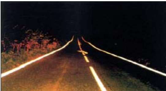
Helenduv teekattemärgistus ja teekattemärgistuses sisalduv klaasist kuulike.
