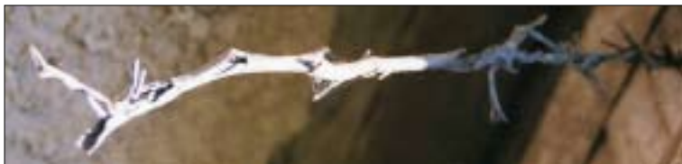
Foto 19. Elektrijuhtme isolatsioon pärast välgutabamust.
