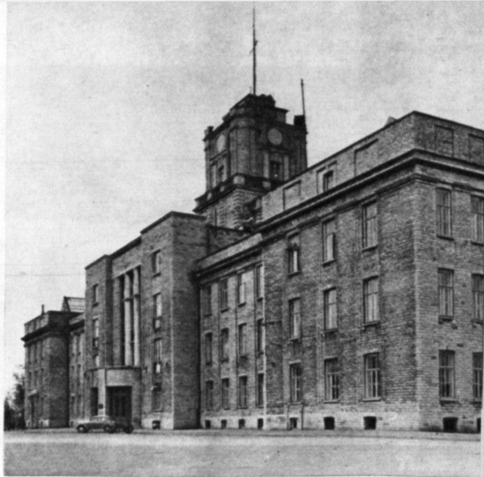
Здание Таллинского политехнического института на оконечности полуострова Копли.
