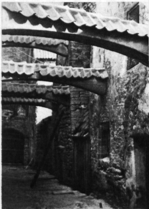
Проход вдоль Екатериненской церкви с опорными сводами церковной стены (XIX в.).
