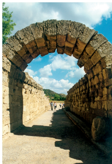
Olümpia. Sissepääs staadionile
