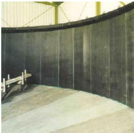
**Гуммирование** - защитное покрытие на основе **резиновых смесей** с последующей их вулканизацией (рис.1.4.2.). Покрытия обладают эластичностью, вибростойкостью, химической стойкостью, водо- и газонепроницаемостью. Для защиты химического оборудования применяют составы на основе натурального каучука и синтетического натрий-бутадиенового каучука, мягких резин, полуэбонитов, эбонитов и других материалов.
