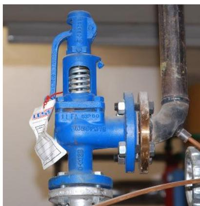
Рис. 2.2.14 Пружинный предохранительный клапан с фланцевым присоединением (1) и устройством ручного открытия клапана (6)
