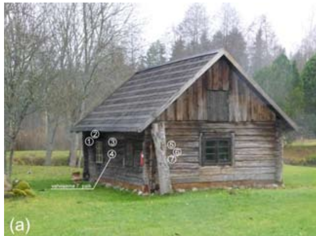
Joonis 3. Proovid võeti sauna siseseintest, puurides torupuuriga palgi poomkanti
