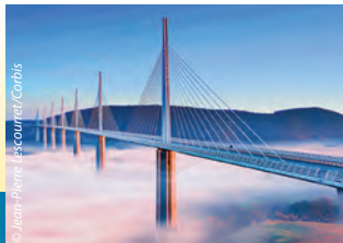
Maailma kõrgeim sild – Millau viadukt (Prantsusmaa).
