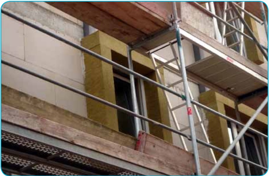
Joonis 3 Passiivmajale paigaldatakse 30 cm soojustuskiht | Pilt: C. von Knorre
