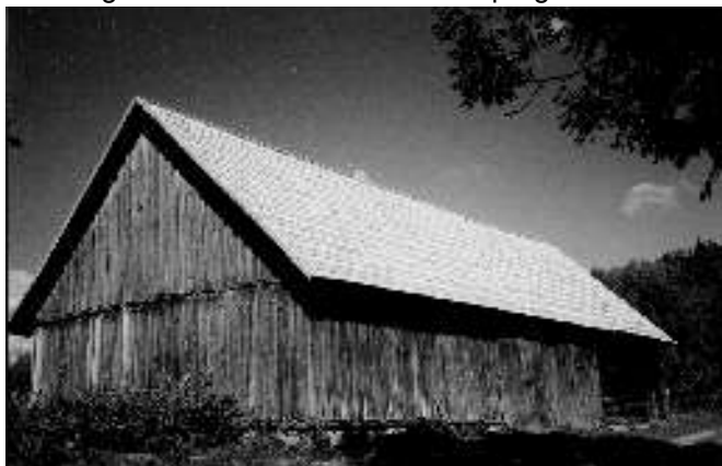
Rehe katuse remontimisel on kasutatud traditsioonilisi materjale.
