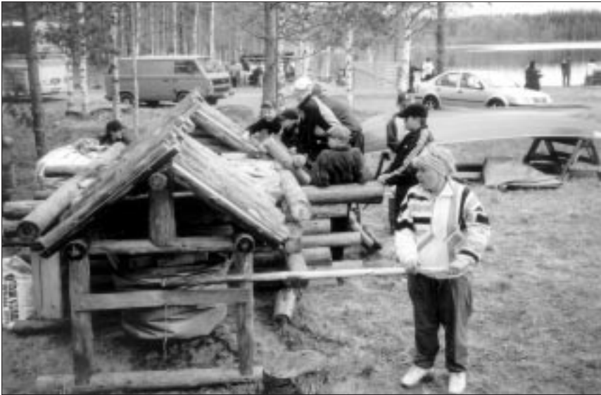
● Säyneise vana rauavabriku uuendatud rauasulatusahju lõõtsaga töötab Enna Lond. MARET LINA fotod
