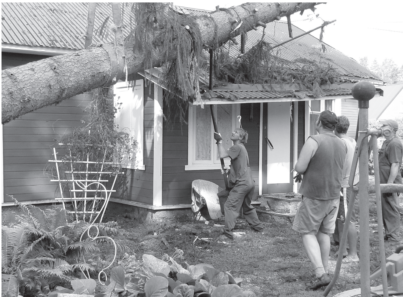
Hiiglasliku kuuse alla jäänud Tartu maantee 44 maja päästis täielikust purunemisest puu tüvesse tunginud tuulekoja katuse tugipost. Fotod: Milvi Kapaun
