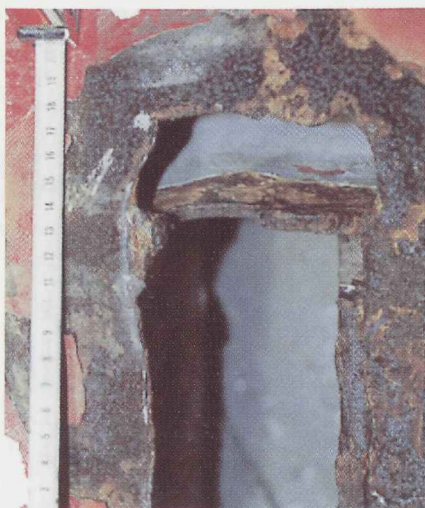
Joonis 12.22. Vasakparda külgluku kõrva kinnituskoha purunemine horisontaalstringeri kohal.
