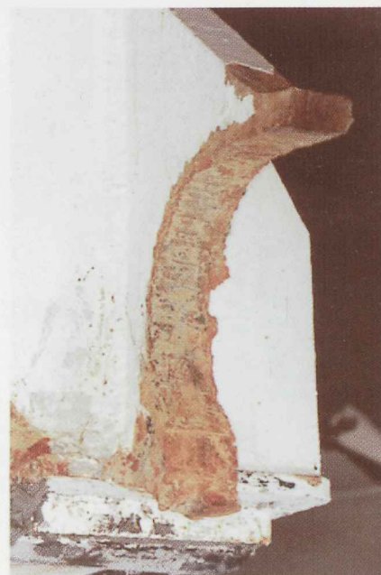
Joonis 8.24. Visiiri paremparda hinge purunenud parempoolne kõrv.
