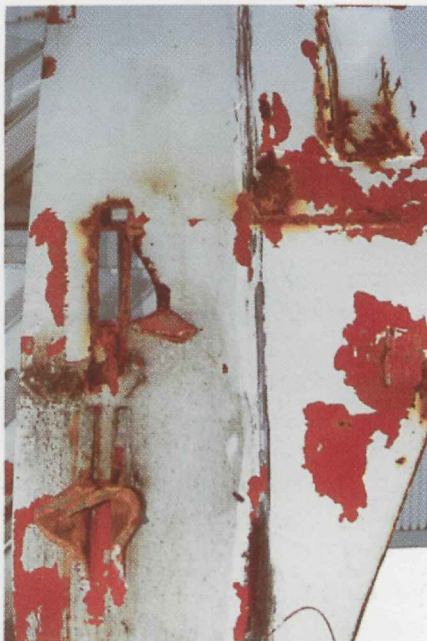
Joonis 8.20. Vigastused visiiri tagaseina paremal küljel külgluku väljarebitud kõrva ümbruses.
