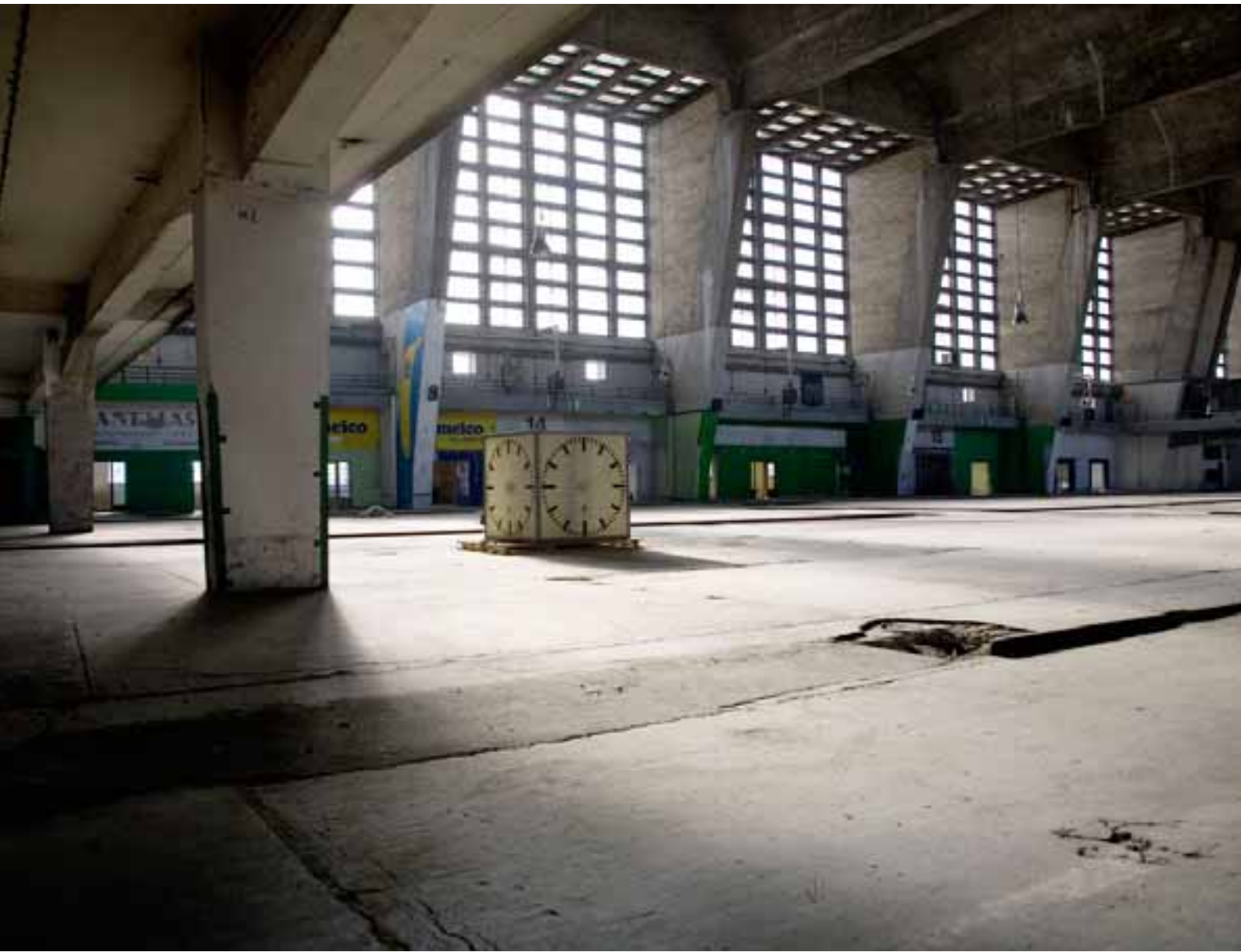
Arhitektuurimälestiste nimekirja kuuluva Grossmarkthalle' sisevaade (veebruar 2008). Martin Elsaesseri projekteeritud Grossmarkthalle oli suurim vabaltkandev raudbetoonehitis maailmas, kui ta 1928. aastal valmis sai.
