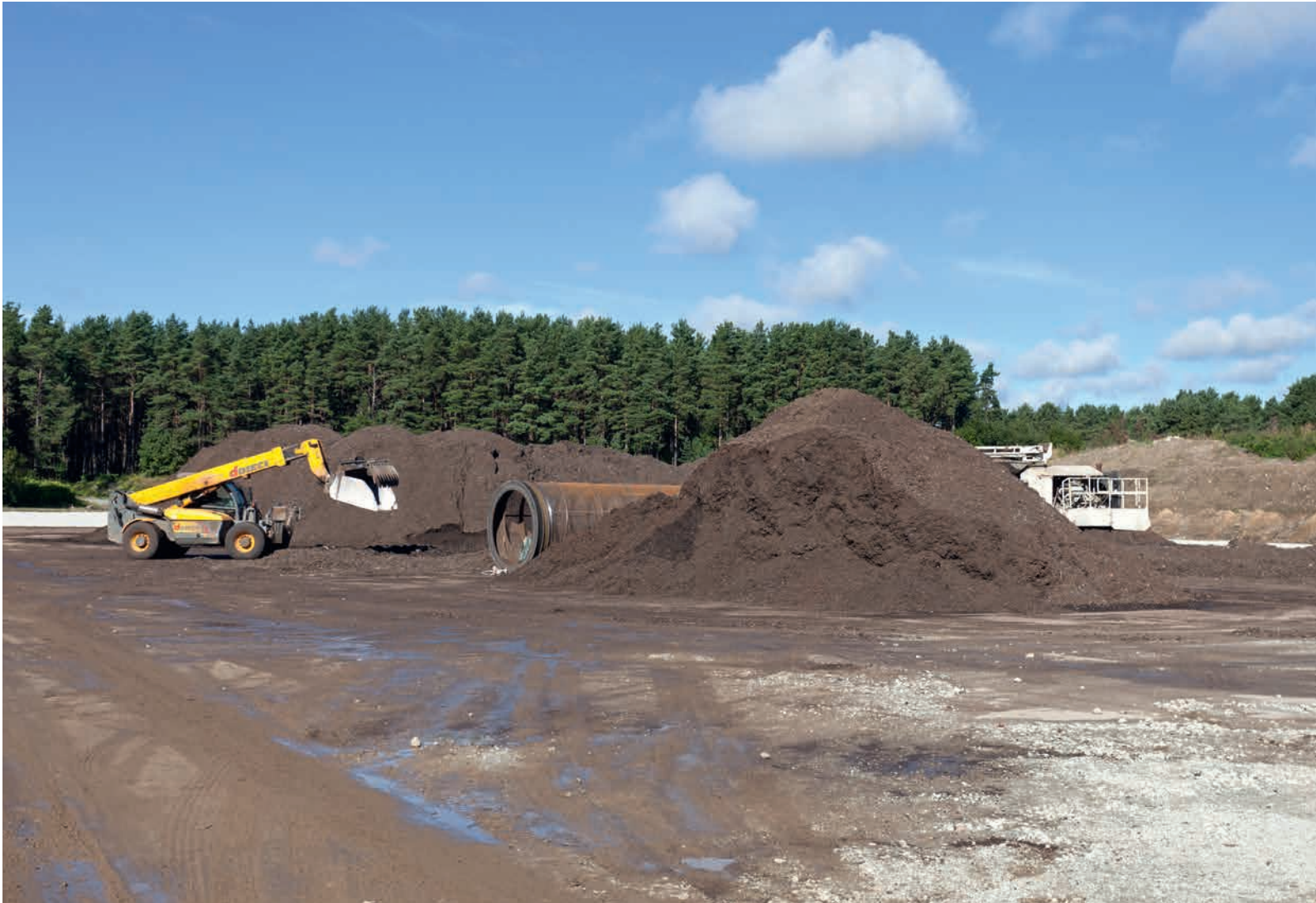
Jäätmejaama rajamine Pärnamäel. Construction of Pärnamäe waste station.
