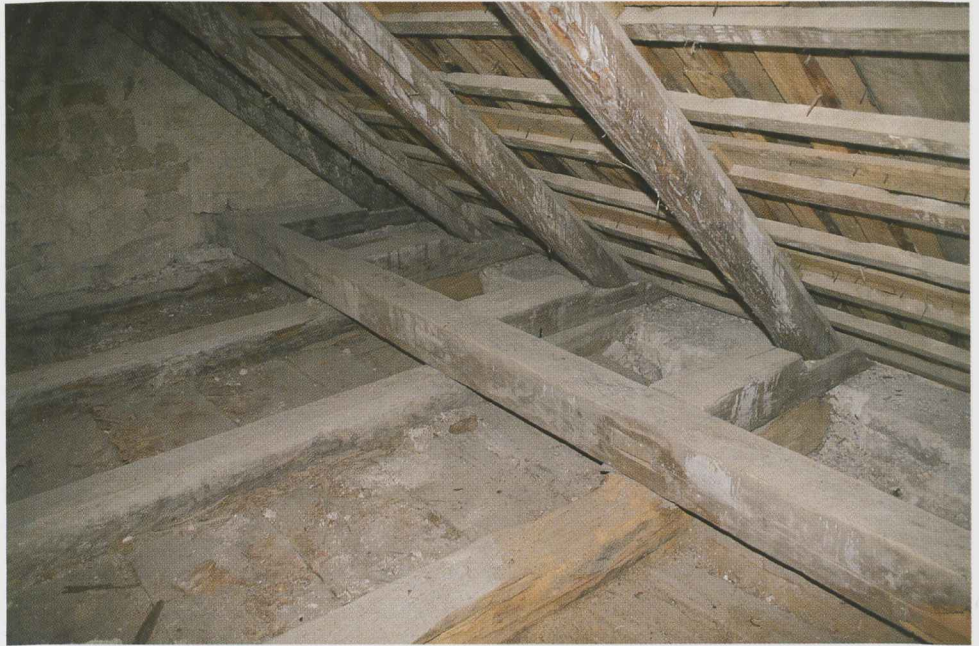
Umbes 150 aastat tagasi remonditud katuseturvik Pidula mõisas (Saare maakond) – ratsionaalne ja ilus töö
