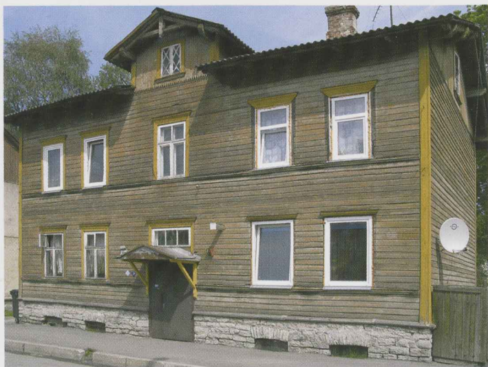
Uued aknad ei järgi pahatihti vanade raamijaotust, rääkimata konstruktsioonidest ja profiilidest, vähe sellest – need ei järgi ka teiste samal majal juba vahetatud akende raamijaotust. Roo 36 Pelgulinna
