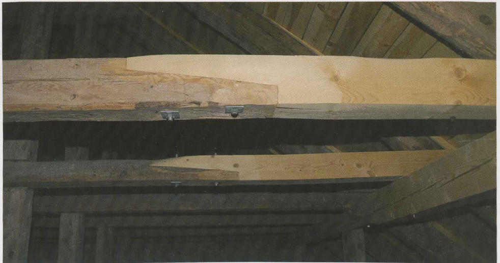
Püha kiriku katusekonstruktsiooni restaureerimisel on maksimaalselt säilitatud ajaloolisi konstruktsiooni osi
