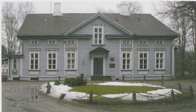
Järeklklassitsistlikus laadis 1860. aastate algusest pärinev puitelamu Veski 4 (oletatav arhitekt C. Rathhaus) kannab juba mõningaid neorenessansi elemente, nagu katuseäärealune poolkorruse (nn. trempelseina) motiiv ja fassaadi pilasterliigendus
