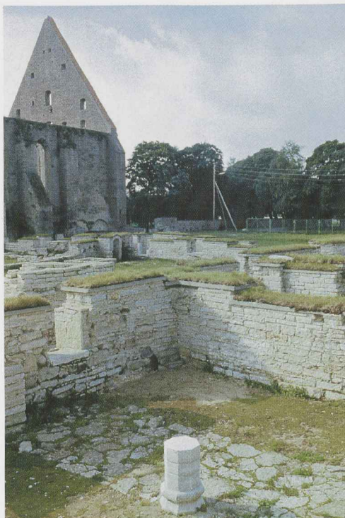
Pirita põhjaklausuuri väljakaevatud, konserveeritud ja mätastatud müürid 1980. a. V. Raami isikukogu Rahvusraamatukogus
