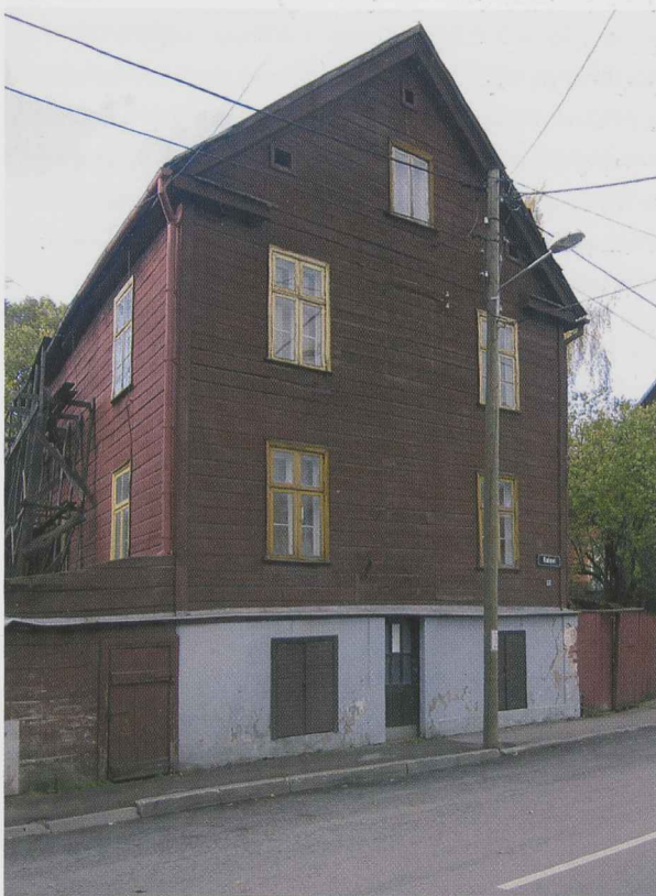
Kalevi 53 kahekorruline puitelamu esindab otsaviiluga tänavale orienteeritud fassaaditüüpi, mille erinevaid variatsioone kohtame mitmel pool linnas
