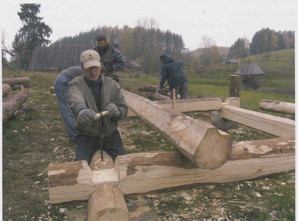
TÜ VKA rahvusliku ehituse esimese kursuse tudengid palkehitud praktilise teiseldatava aida väljavahetatavate palgiridade asemele uusi tegemas. Esiplaanil Egon Römer, tema taga Kristi Ristmägi, seisab juhendaja Priit-Kalev Parts, taamal Tarmo Tammekivi. Tegevus toimus 2005. aasta oktoobris Karula rahvuspargis, Mundi talu õues
