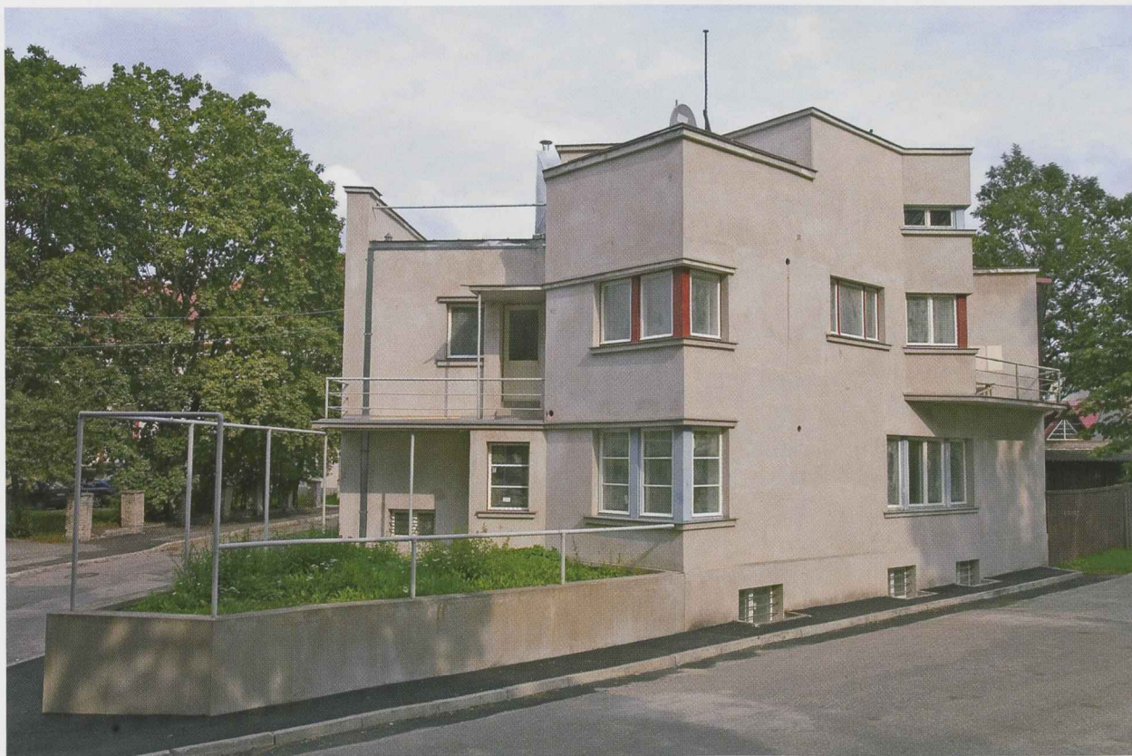
Siinmaa villa etapis, kus alumisel korrusel olid jäänud veel helesinised aknaraamid, mis värviti kõige alumise sondaakriki järgi, ülakorrus sai lõpliku lahenduse rauameninguga. Foto: V. Kruuser, Eesti Ekspress
