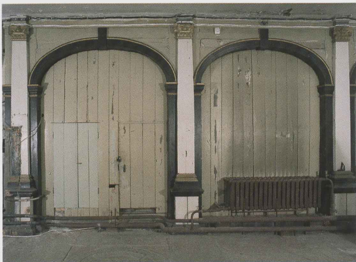
Dekoratiivne sein enne väljapuhastamist ja puiduproteeside tegemist. Fotod: P. Säre
