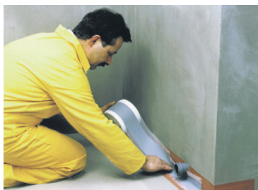
Hüdroisolatsioonilindi weber.tec 828 paigaldamine
