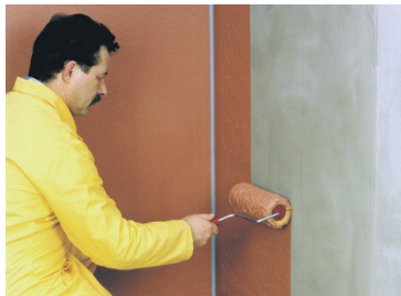
Hüdroisolatsioonimassi weber.tec 822 seinale kandmine maalirulliga
