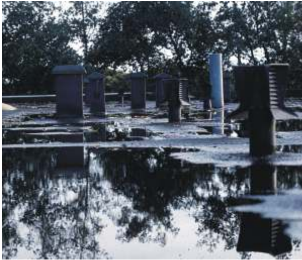
Joonis 37. Lamekatuse pind võib aja jooksul painduda nii, et sademete äravool on häiritud ja katusele tekib seisev vesi.
