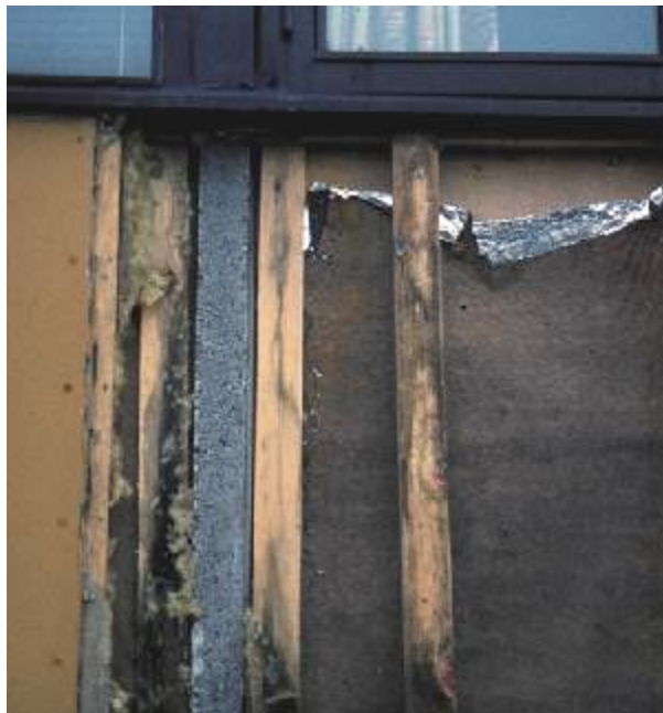
Joonis 10. Kui ehituskonstruktsioonide sees kasvab seeni, ei pruugi seente eoseid ruumide õhus leiduda, kuigi seente elutegevuse tagajärjel tekkivad kergesti lenduvad ühendid (VOC) mõjutavad ruumi kliimat.
