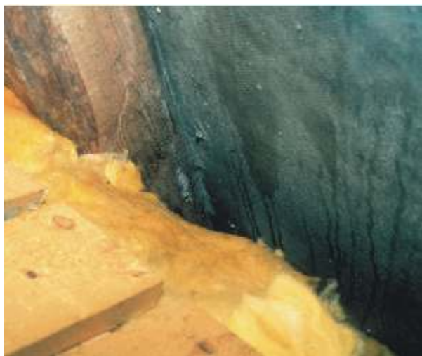
Joonis 34. Vee kondenseerumine katusekattematerjali alla paigaldatud kilel tekitab sageli soodsad tingimused hallitussente kasvuks.
