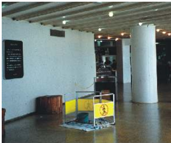
Joonis 33. Läbitilkuv katus tuleb kohe parandada. Ämbrite kasutamine läbijooksu all pole lahendus, sest katusekonstruktsioonid kahjustuvad niiskuse toimel.
