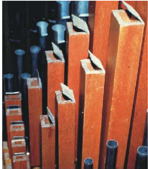
Joonis 18. Hallitused puidust torudel, mida ei ole enne kohale asetamist piisavalt kuivatatud.
