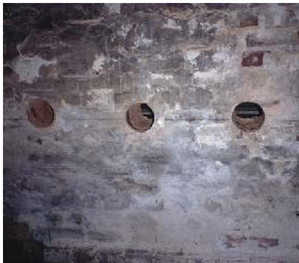
Joonis 56. Keldri õhutamiseks võib vaheseintesse augud puurida.
