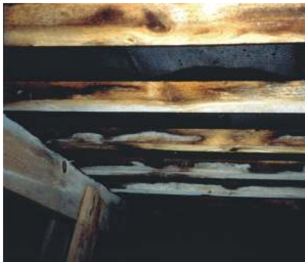
Joonis 35. Kui katusealuses ruumis on õhu vaba liikumine takistatud, võivad laelaudadel ja taladel areneda hallitussened.
