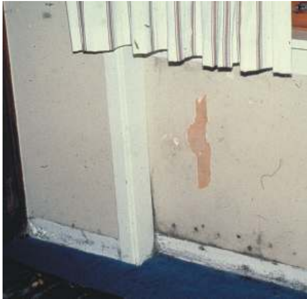
Joonis 40. Kui õhuniiskus on püsivalt kõrge, tekib külmasildadele ja väiksema õhu liikumisega kohtadesse (näiteks seinä äärde paigutatud mööbli tagusele seinale) kondensatsioonivesi.
