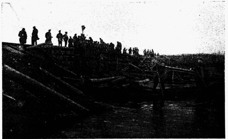
Soomusrongide Diviisi poolt 13.—18. aprillini ehitatud ajutine raudteesild Piusa jõel, Petseri jaama lähedal. (Endise ajutise silla viis ära kevadine suurvesi. Silla pikkus 15 silda, kõrgus 3,5 silda.)
