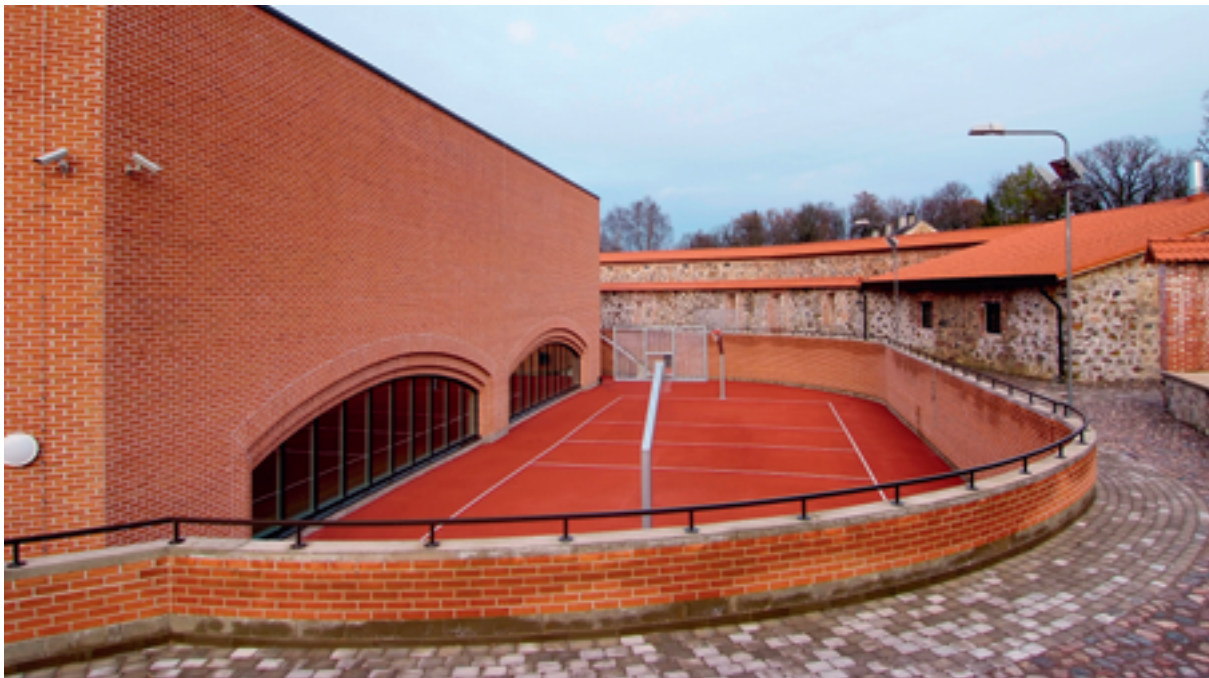
Raudna Põhikooli spordihoone Raudna Elementary School gymnasium
