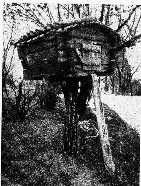
Kaks lapi aita Stokholmis Skanseni Vabaõhumuseumis Aidad on ehitatud postide otsa, et loomad ei pääseks neid lõhkuma
