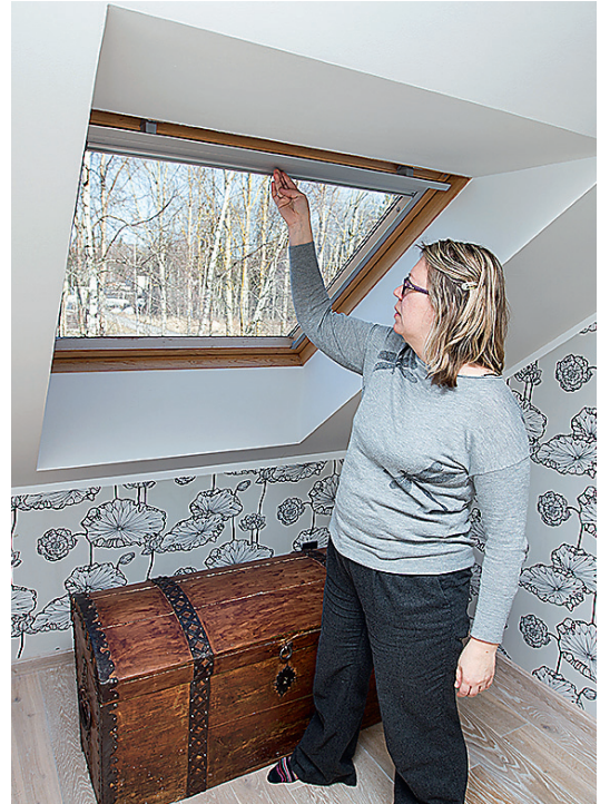
↑ KATUSEAKENDE põsed, mis remondi järel on poole paksemad, reedavad tõhusamat soojustust.
