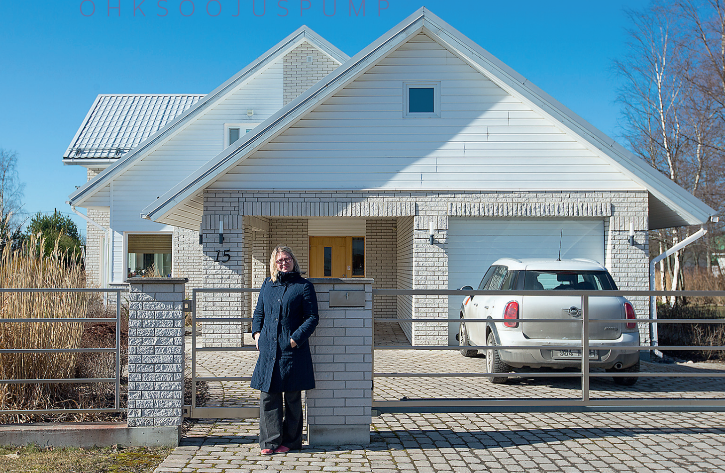
↑ PILLE Petersoo paigaldas 1990ndate lõpul ehitatud majja õhksoojuspumba ning soojustas seinad. FOTOD: EIKO KINK
