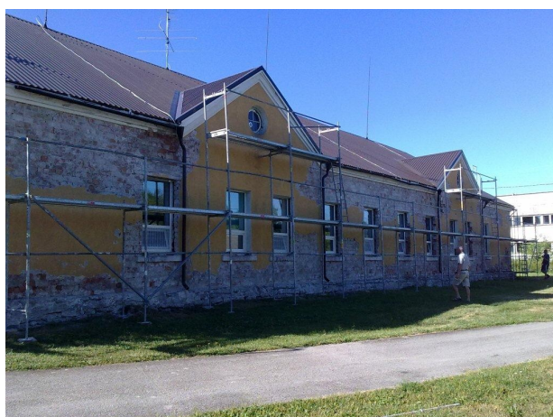
Risti Hooldekodu renoveerimine
