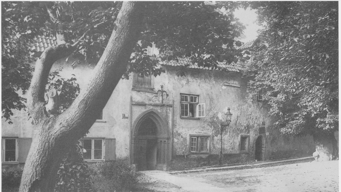
Riddargatan 3, Reval, svenska församlingens gamla prästgårdsbyggnad. Här inrymdes svenska skolan och Svenska Folkförbundets, Svenska Odlingens Vänners och Kustbons gemensamma expedition. Lilla porten till höger är ingången till skolan och expeditionerna. Byggnaden som också inrymde den tyska S:t Nikolai församlingens expedition, utplånades den 9 mars 1944 genom rysk terrorbombning. Foto: Parikas.
