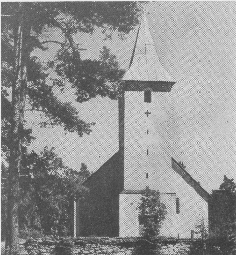
I kanten av Kappelmon mellan byarna Roslep, Bergsby och Ölbäck ligger Roslep kapell, där vägarna från de nordliga byarna går samman i stora landsvägen söderut. Foto Joh. Triefeldt 1939
