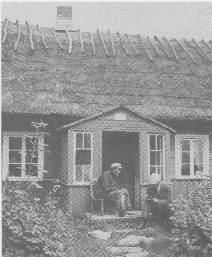
Halmtak med hänglar överst över taknocken. Foto Per Söderbäck
