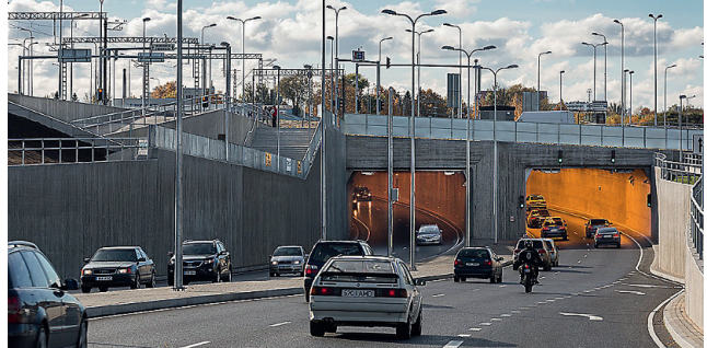
ÜLEMISTE liiklussõlm Tallinnas. FOTO: EESTI BETOONIÜHING
