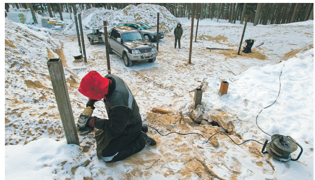
MULLU veebruaris sai maja vundamenti.
