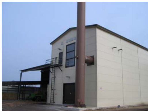
Рис. 8.42. Работающая на биотопливе котельная Peetri в Пайде (фото Ю. Касък)
