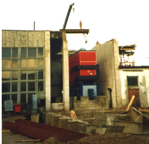
Рис. 8.6. Монтаж комплексной котельной установки в котельной Tehnika (фото В. Варес)
