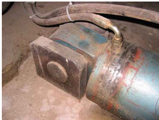
Рис. 8.29. Приваренный торец гидравлического цилиндра (фото Ю. Каськ)
