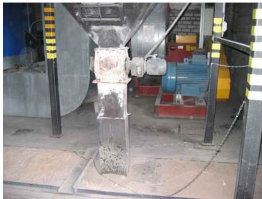
Рис. 8.36. Основание мультициклона и бетонированная крышка канала (фото Ю. Каськ)
