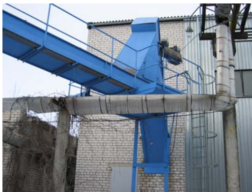
Рис. 8.19. Трубопроводы, препятствующие строительству транспортера топлива в котельную (фото Ю. Каськ)
