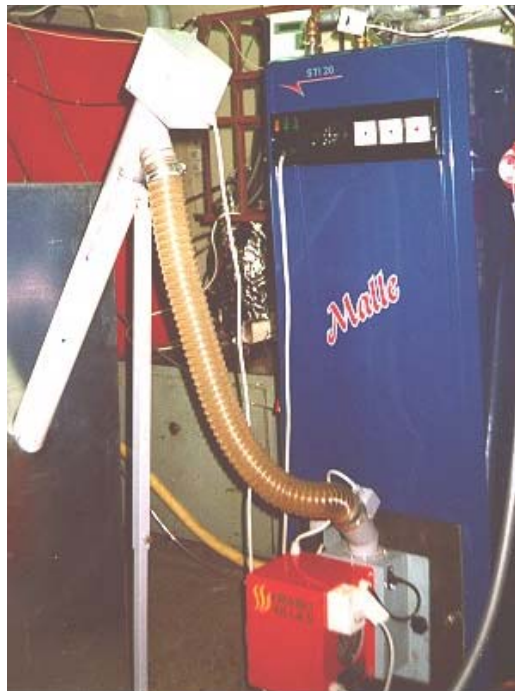
Рис. 4.27. Малый котел Malle (20 кВт) с горелкой для пеллетов и системой подачи пеллетов
