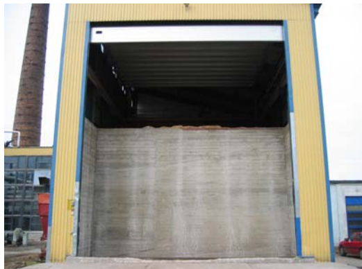
Рис. 8.9. Топливный склад котельной Tehnika (фото Ю. Касък)
