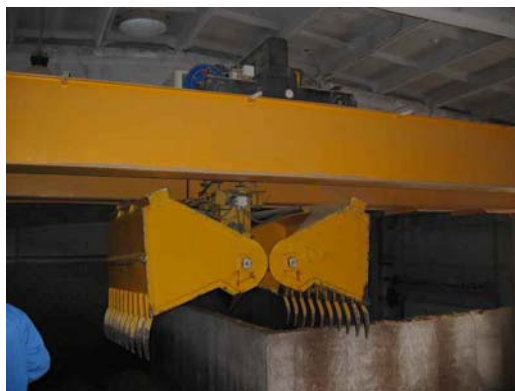
Рис. 8.38. Мостовой кран с изготовленным в Эстонии грейфером (фото Ю. Касък)
