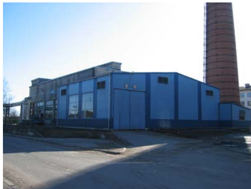
Рис. 8.33. Котельная в Хаапсалу после реконструкции (фото Ю. Касък)
