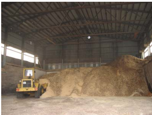
Рис. 8.28. Погрузка топлива на складе котельной Männitmäe (фото Ю. Каськ)
