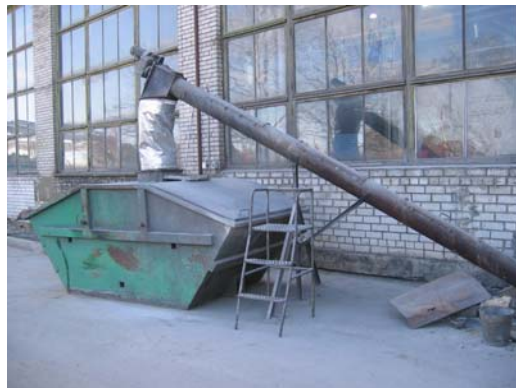
А. Контейнер золы с шнековым транспортером
