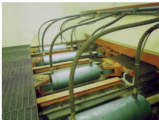
Рис. 5.6. Гидроцилиндры привода скребков (Saxlund)
