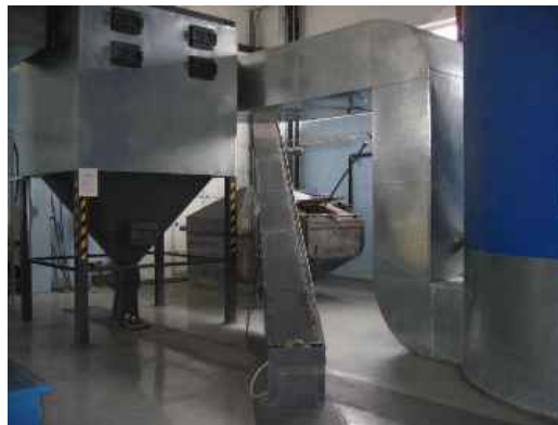
Рис. 8.41. Мультициклон и транспортер золы (фото Ю. Касък)
