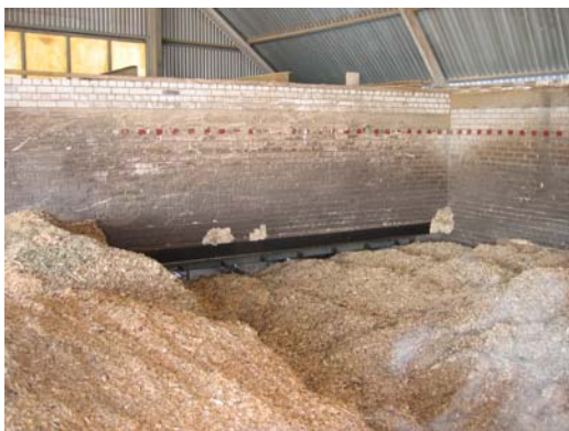
Рис. 8.24. Часть топливного склада котельной Vöbrisoo с движущимся штанговым толкателем (фото Ю. Каськ)
