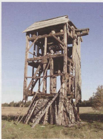
Osalt lammutatud tuulikut parandati talgute korras.
