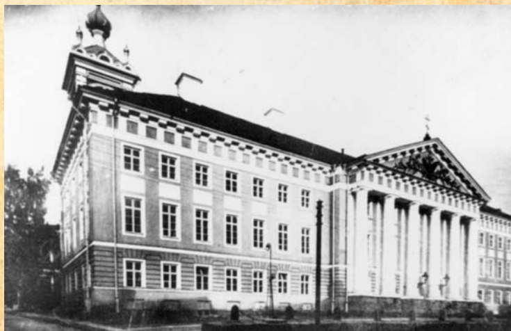
1895. aastat ehitati peahoonesse õigeusu kabel ja hiljem selle katusele kellatorn.
