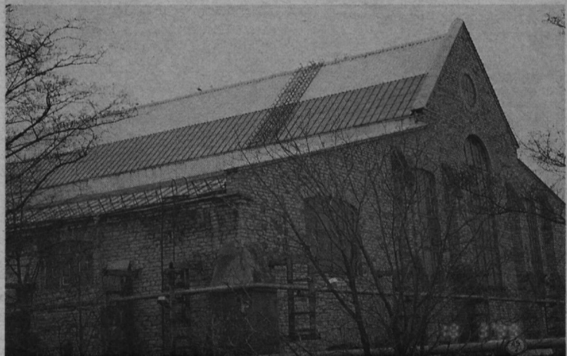
Värske katusega kolmelööviline diisliitsehhi. Kunagisel Euroopa suurimal klaaskatusega tööstushoonel ulatus klaas tollal katuseharjani.
