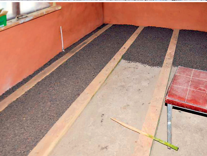
Soojustusplaatide, betoonplaadi ning kergkruusaga soojustatud põrand.
