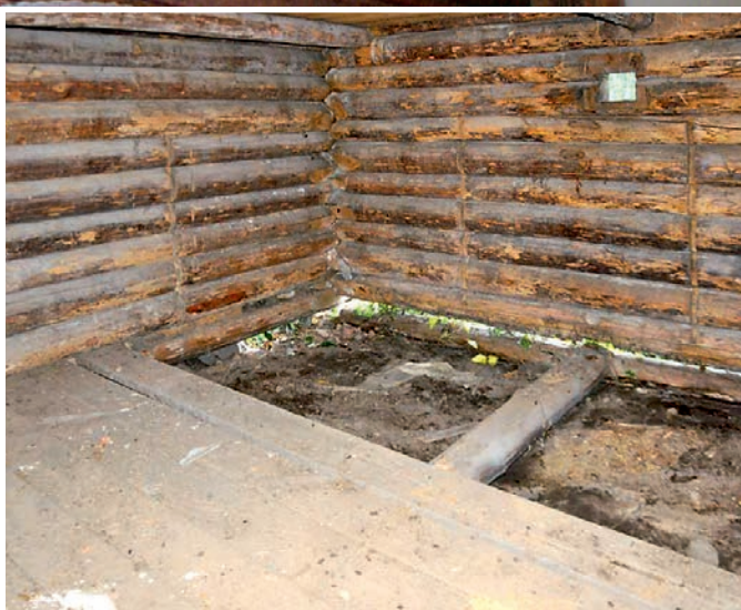
Soojal ajal kasutatava aida põrand on soojustamata, traditsiooniline tuulutatav põrand.
