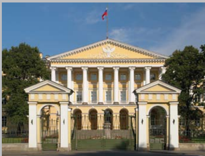
Смольный институт, ныне мэрия г. Санкт-Петербурга
