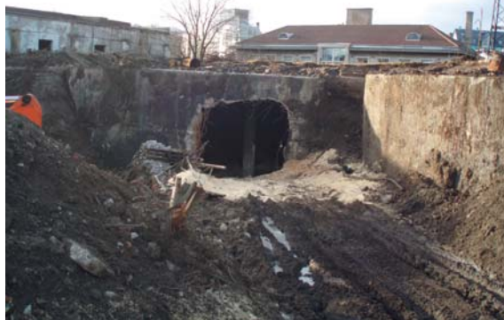
Nii nägi Põhja puistee masuudihoidla välja koristustööde alguses Foto: Keskonnainspektsioon
