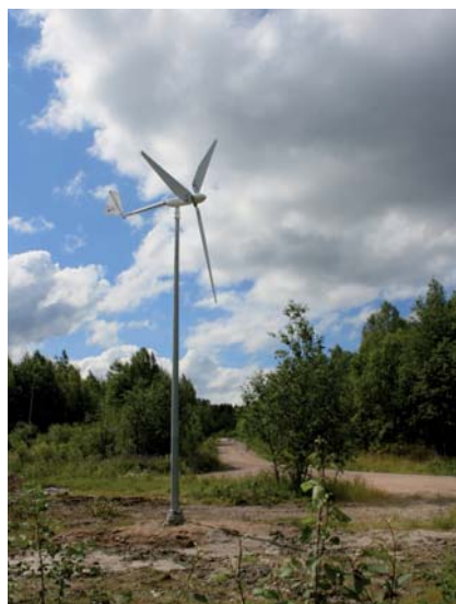
Elektrituulik võimsusega 2 kW
