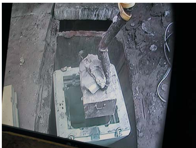
Metallkasti paigutamine betoonkonteinerisse
