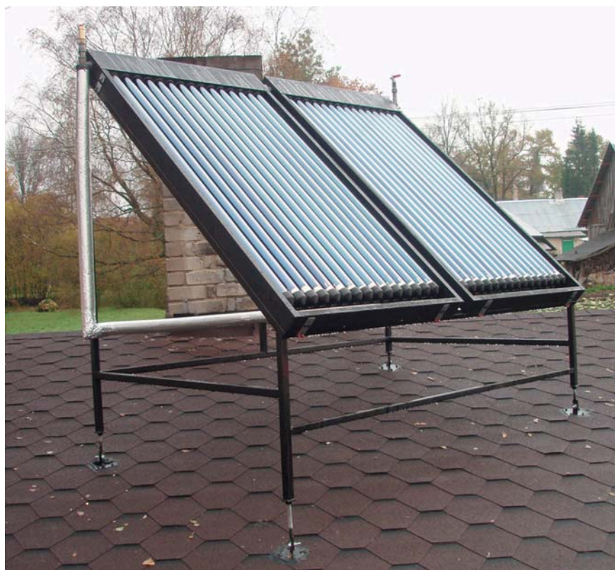
Joonis 3. Kaks 1 m 2 suurust päikeseküttekollektorit eramu katusel Põlvemaal
