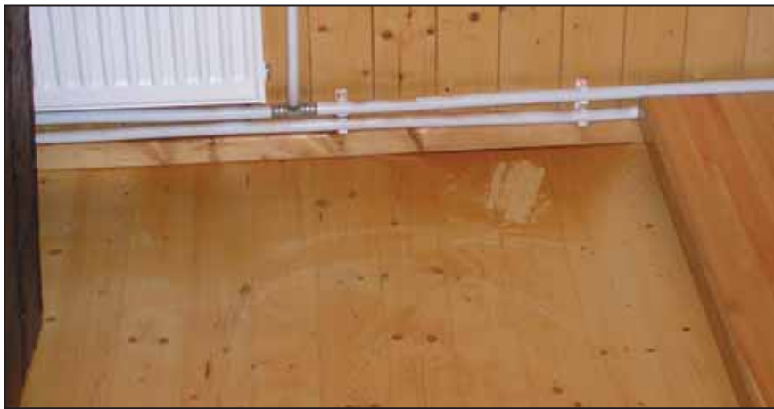
FOTO 11. EOSTOLM PÕRANDALAUAL Foto: Kalle Pilt
