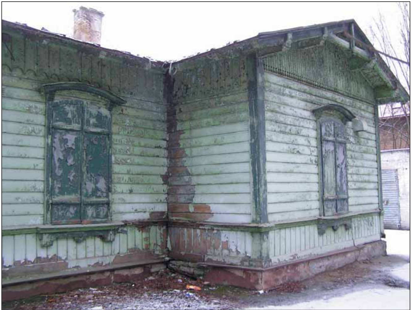
FOTO 6. NEED SEINAD ON NII TUGEVASTI KAHJUSTATUD, ET ENNE REMONDIMEHE KOHALEJÕUDMIST VÄLJAEHTIS LAGUNES
