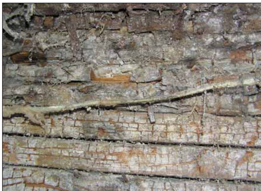
FOTO 1. PRUUNMÄDANIKUGA KAHJUSTATUD SEIN
