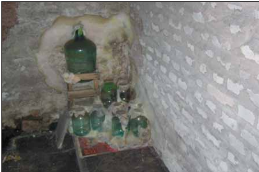
FOTO 10. SEENENIIDISTIK LEVIB NII KLAASIL KUI PUIDUL Foto: Kalle Pilt
