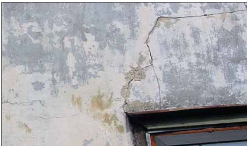
FOTO 5. PRAOD KROHVIS VIITAVAD NIISKUS- VÕI SEENKAHJUSTUSELE
