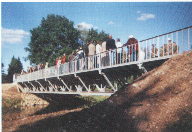
Jõeküla silla avamine 5. septembril 2000. Mitu aastakümnet tagasi hävinud silla asemele ehitati monteeritavatest terassillasõrestiku elementidest (SARM) uus, mis üle Põltsamaa jõe ühendab Jõgeva ja Järva maakonda. Foto: Friedrich Sats
