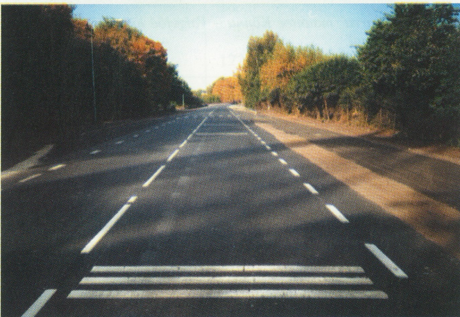
Viimsi – Rohuneeme tee. Oktoober, 2000. Pildil on näha kolmekordne plastikust ristmarkeering enne jalakäijate ülekäigurada, mis kordub ülekäigurajale lähenedes veel kahe- ja ühekordsena, hoiatades juhti nii visuaalselt kui väikeste raputustega. Idee on Kaljo Kaldamilt
