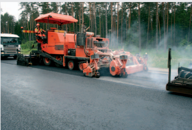
Kuumutatud kate freesimine ja taaslaotamine
