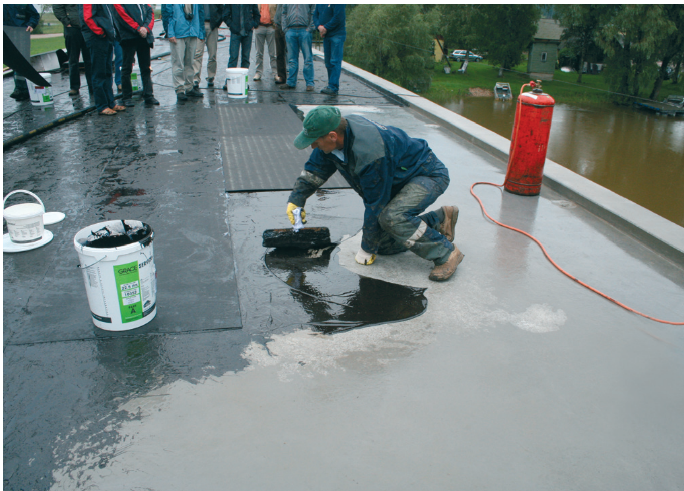
Vedelmembraani Servidek paigaldamine
