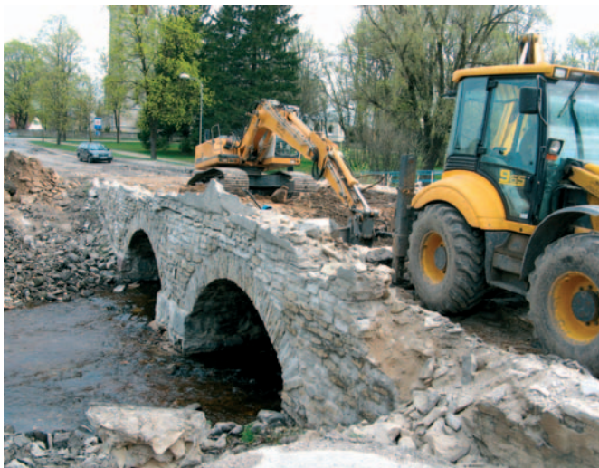
Ballasti eemaldamine ja võlvide vabastamine
