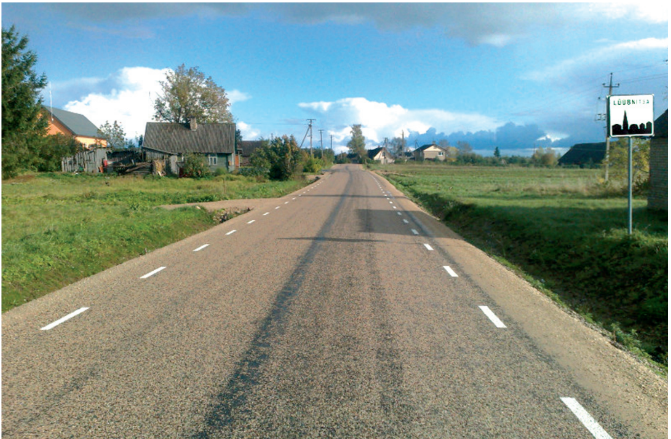
Uus freesimispurust kattega tee Lüübnitsas
