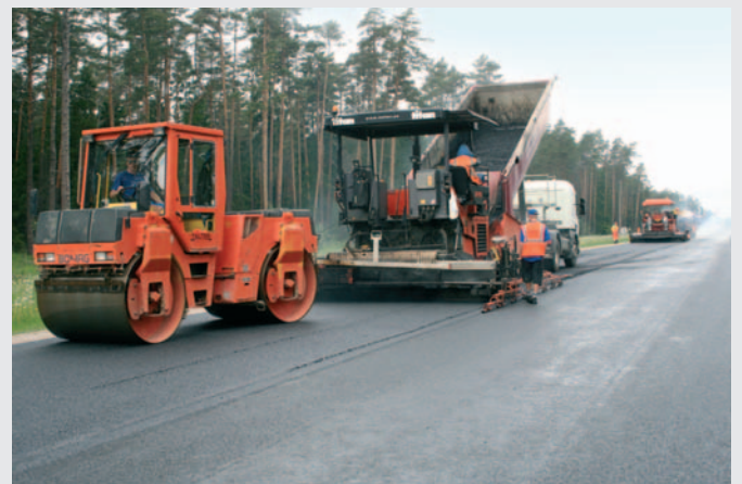
Uue kate laotamine ja kinnirullimine
