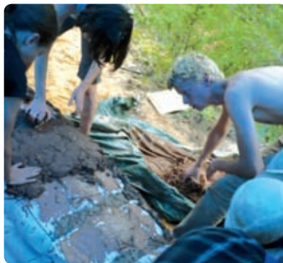
• KIHT COB -MÖRTI LÄHEB VUNDAMENDI PEALE.
