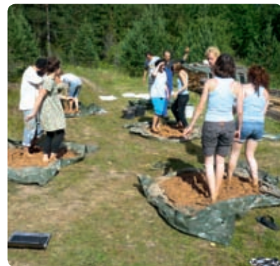
• COB -MÖRTI SÕTKUTAKSE JALGADEGA.
