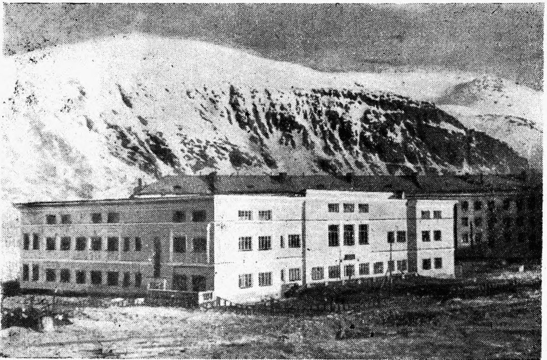
Ilus lastesõime maja Kirovski linnas. Majas on 64 tuba. Üldine pindala on 1460 ruutmeetrit.. Siin asuvad: söögisaal, mängutoad, vannitoad jne. Lastesõime mahub 152 last.
