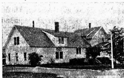
Puhas korralik muru ja hoone värv muretsesid I auhinna Evergreeni juustutööstusele.
