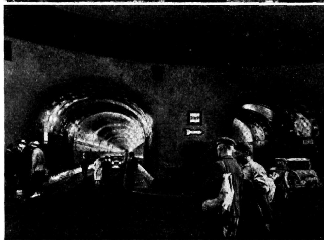
Ülal: St. Pauli sadamasild ja Elbe tunneli suu Hamburgis. All: Vaade Elbe tunnelisse, mis 21 m sügavusest ja 450 m pikkuselt läheb jõe alt (auriku kohalt) läbi
