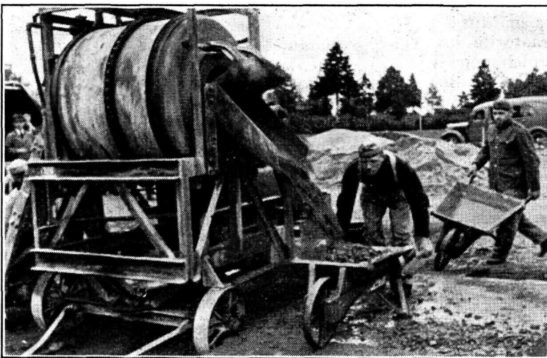
Betoonisegaja sillaehitustöödel.
