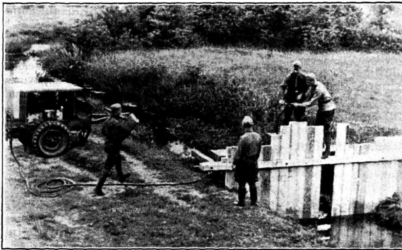
Vee paisutamiseks puntseina ehitamine kompressorrämmi abil.
