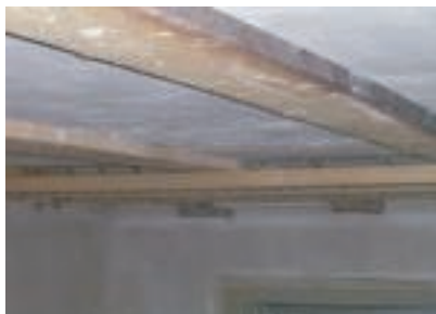
Puittaladest lagi olemasolevas ehitises
