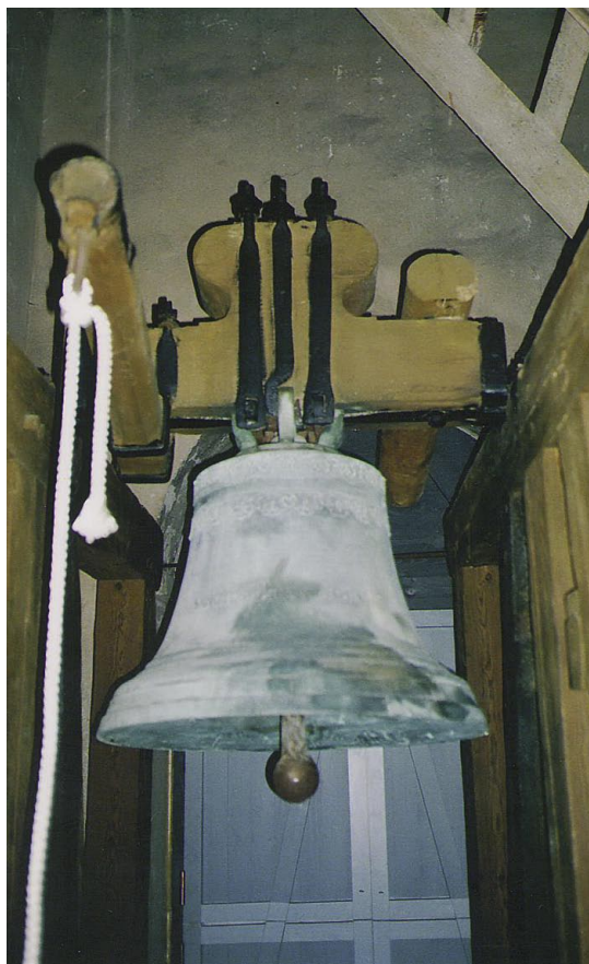
47. Во время звона колокол раскачивают вместе с маточником при помощи веревки или троса, привязанного к концу палки, которая прикреплена к маточнику. Фото: М. Лойт
