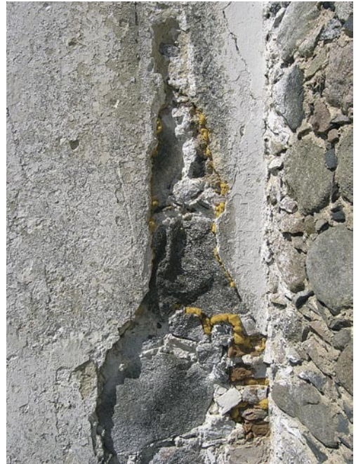
1. Монтажная пена впитывает воду, как губка. Фото: К. Тооминг
