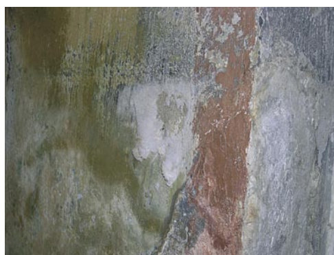
16. Белесые отложения кристаллизованных солей, похожие на вату. Фото: К. Тооминг
