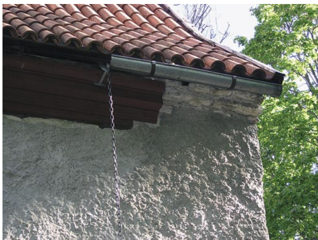
12. Цепочка, прикрепленная к желобу стрехи, прекрасно заменяет водосточную трубу. Фото: К. Тооминг
