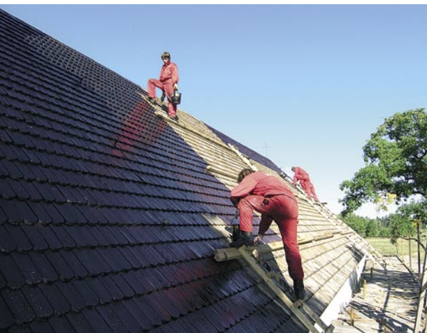
8. Осмаление крыши, крытой scuлами. Сообща работа идет быстрее. Фото: К. Тооминг
