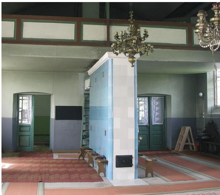
55. Отремонтированная оригинальная печь. Фото: Ю. Юкк
