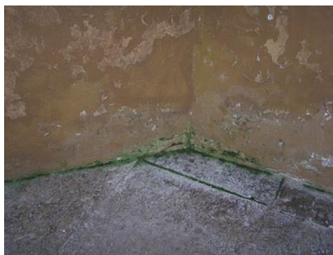
15. Зеленые водоросли сигнализируют об излишней влажности стен. Фото: М.-Л. Паавер
