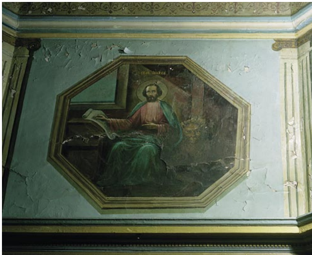
53. Повреждения, вызванные излишней влажностью, на настенной росписи. Фото: П. Сяре
