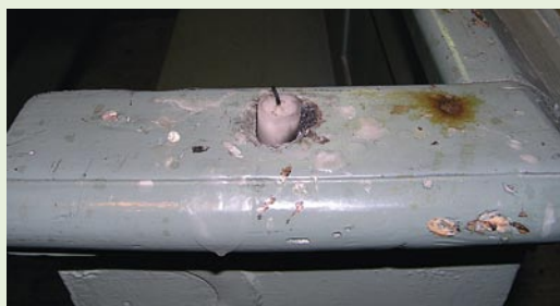
61. Свеча, находящаяся в непосредственной близости от легко воспламеняющейся поверхности. Фото: К. Тооминг
