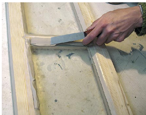
23. Разглаживание замазки при помощи специального шпателя. Фото: К. Зова
