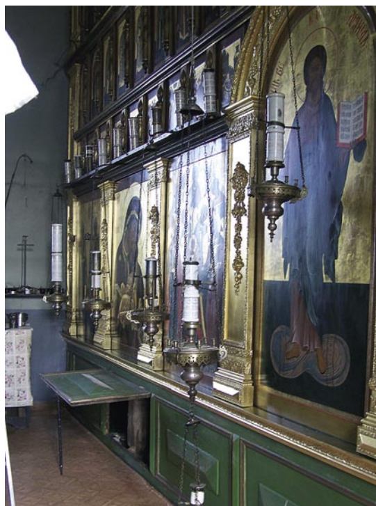
52. Вентиляционные отверстия старообрядческого иконостаса препятствуют скоплению излишней влаги между стеной и иконостасом. Фото: М.-Л. Паавер
