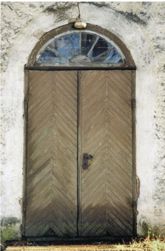
21. Со временем сильно прогнившая из-за постоянного попадания дождевой воды древесина нижней части двери. Фото: К. Тооминг
