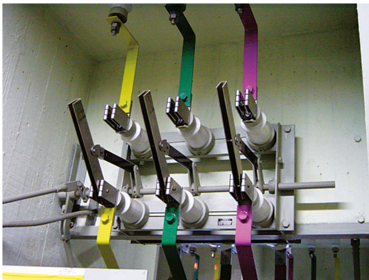
Joonis 32.3. Lahklüliti avatuna (pöörake tähelepanu vanadele faaside värvitähistele).
