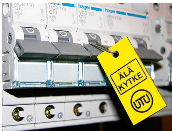
Joonis 32.5. Liinikaitselüliti väljalülitatuna ja lukustatuna.
