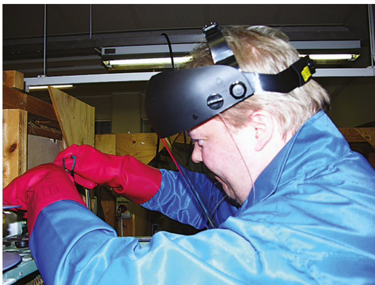
Pilt 32.17. Kui kaitsekiiver pole muudel põhjustel nõutav, piisab pingevalustel töödel näokaitsest.
