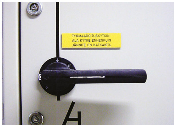
Joonis 32.8. Töömaanduslüliti. Ära kasuta enne pinge väljalülitamist.
