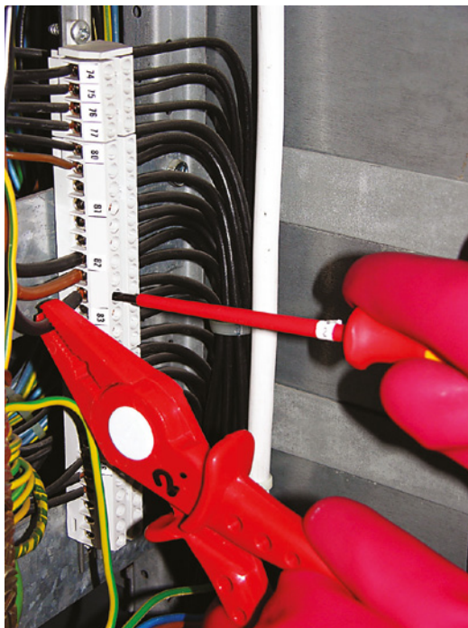
Pilt 32.13. Juhtimisahela ümberehitustööd on pingeluse tööna lubatud.
