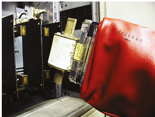
Pilt 32.18. Haaratsiga vahetatavate sulavkaitsmete vahetamisel tuleb elektrikaareohu tõttu kasutada varrukaga haaratsit.
