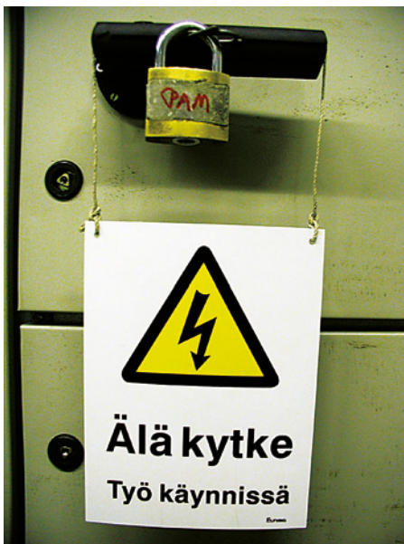
Joonis 32.6. Lahutuskohas peab olema hoiatussilt ja lukk.
