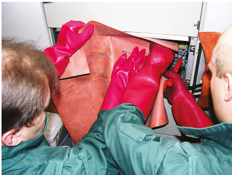
Joonis 32.10. Töötajad kaitsevad end juhusliku kokkupuute eest isoleeriva lisakaitsevahendiga. Ärge unustage isoleerkindaid katete paigaldamisel.
