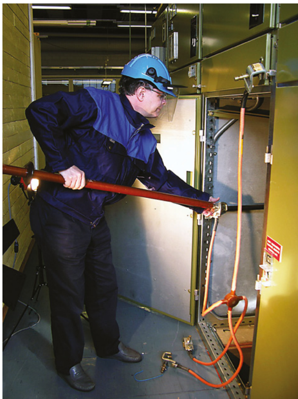
Joonis 32.9. Töömaandamis protsessi alustamine kantava maandusvahendiga.
