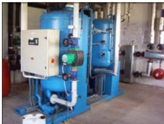
Joonis 5-15: Absorptsioonkylmutusseade ühes biogaasijaamas.
