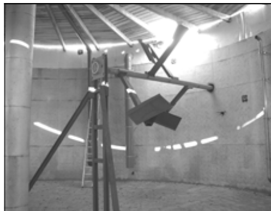
Joonis 3-39: Mõlasegisti (paremal); foto: PlanET Energietechnik.
