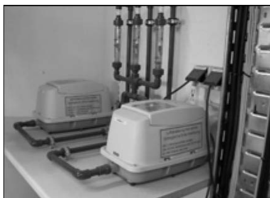
Joonis 5-1: Gaasi reguleerimine õhu pumpamisel käärituskambrisse; foto: Institut für Energetik und Umwelt gGmbH.
