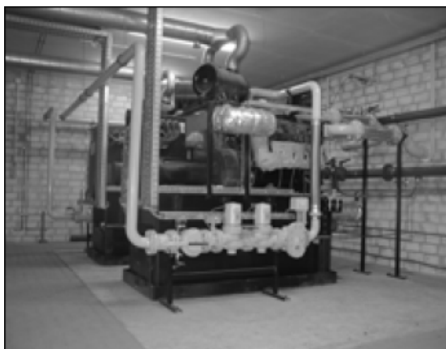
Joonis 5-7: SEK koos gaasi reguleerimissõlmega (hele torustik); foto: MT-Energie GmbH.
