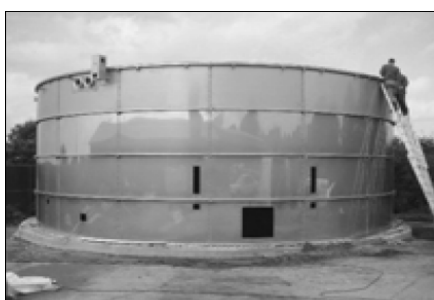
Joonis 3-34: Metallist käärituskambri ehitus; foto Anlagen- und Apparatebau Lütke.
