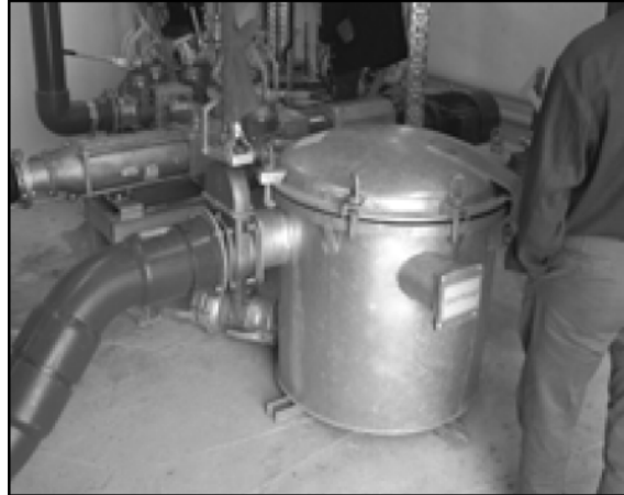
Joonis 3-29: Väävlialdaja; foto: Institut für Energetik und Umwelt GmbH.
