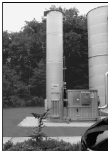
Joonis 3-43: Biogaasijaama küünalpõleti, foto: Haase Umwelttechnik AG.
